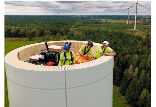
Deutlich zu erkennen: die halbkreisförmigen Holzmodule.
