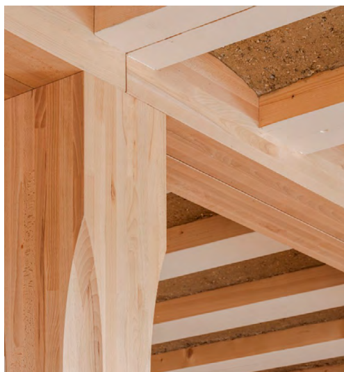
Präzise gefertigtes Ineinander von Balken: Detail aus dem Bürogebäude „Hortus“ bei Basel.
