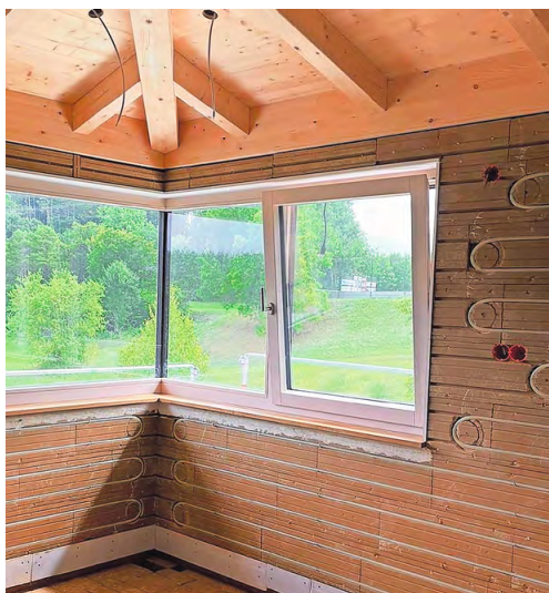
Ideal zum Verlegen einer Wandheizung: eine Kulisse aus gestampftem Lehm.
