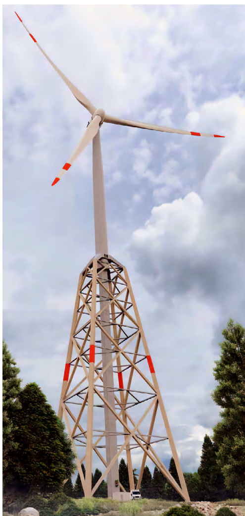
Holz statt Stahl: Das österreichische Unternehmen Hasslacher Green Tower setzt auf Holz-Hybrid-Türme für Windkraftanlagen bis sechs MW.
