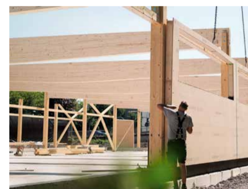
Mit voller Absicht auf dem Holzweg: Holzbauweise bei einem ALDI-Markt in Gelsenkirchen.
